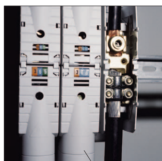
Соединение медных и алюминиевых проводников
